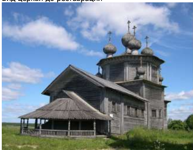
Вид церкви до реставрации
