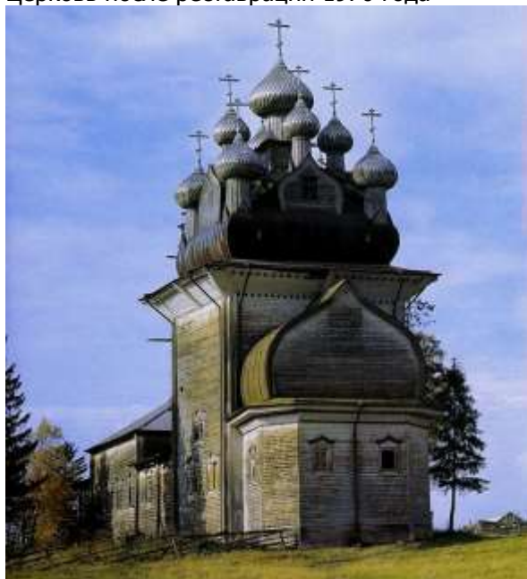
Церковь после реставрации 1970 года
