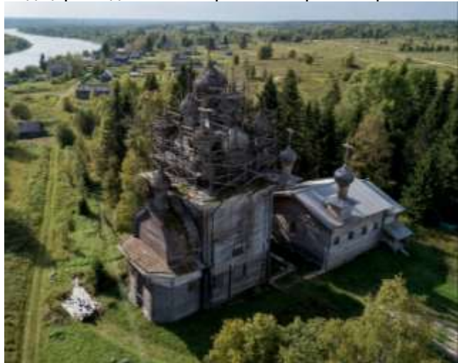
Вид церкви до начала противоаварийных работ
