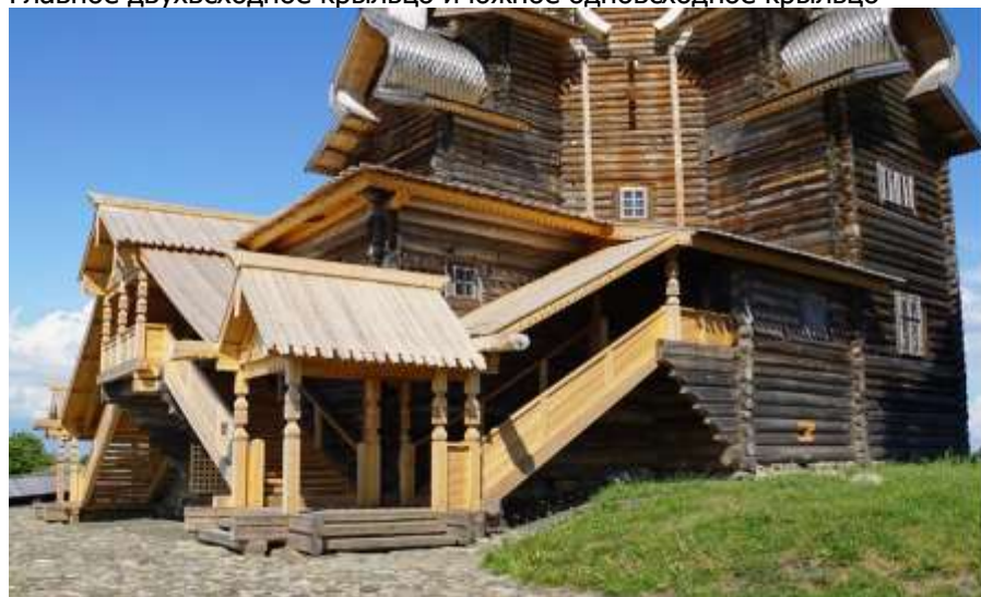
Главное двухвсходное крыльцо и южное одновсходное крыльцо
