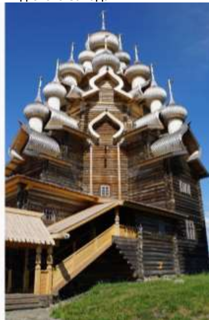
Вид с юго-запада
